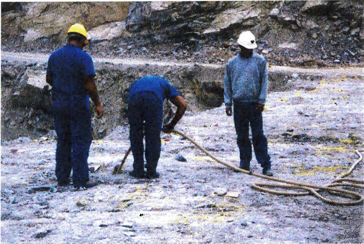
Foto 5 - carregamento mecanizado de emulsão
